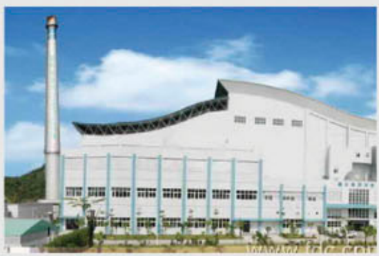
北京高安屯垃圾处理中心
